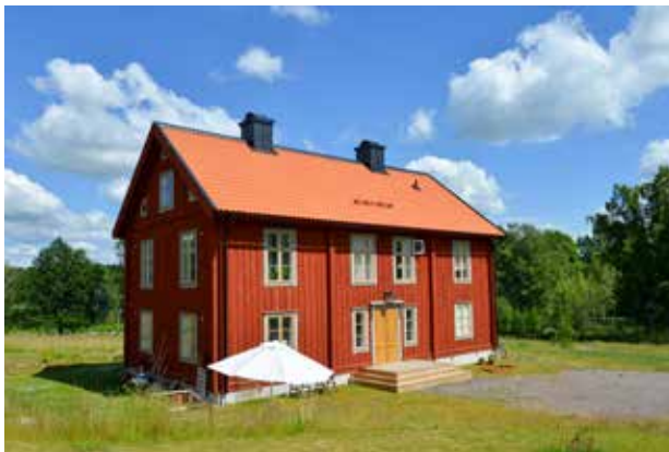
Detta hus i Snavlundabygden är nybyggt av en gammal timmerstomme som är hitflyttad från grannkommunen.
