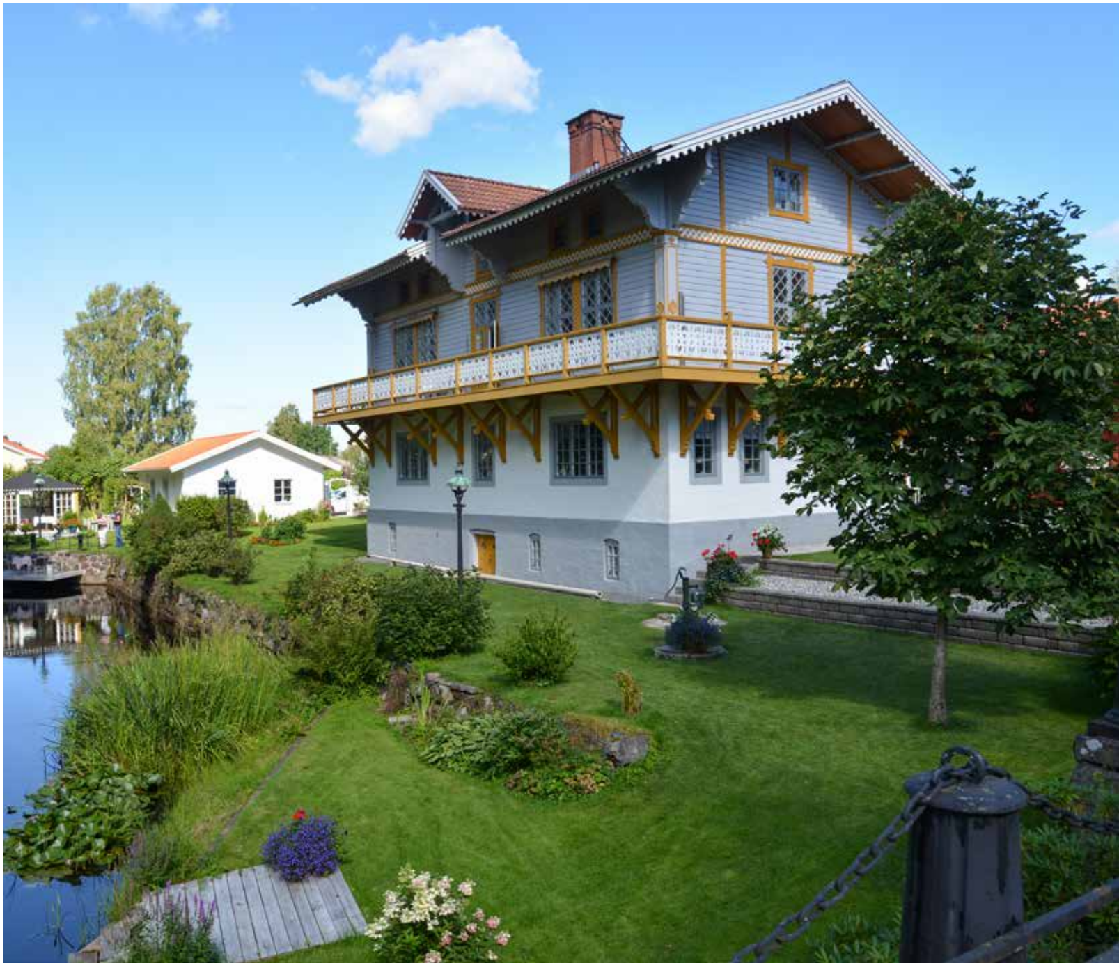
Hus i schweizerstil i Laxå där energiska ägare skrapat bort det vita och bruna och hittat husets ursprungsfärger och även kittat om 900 fönsterrutor.
