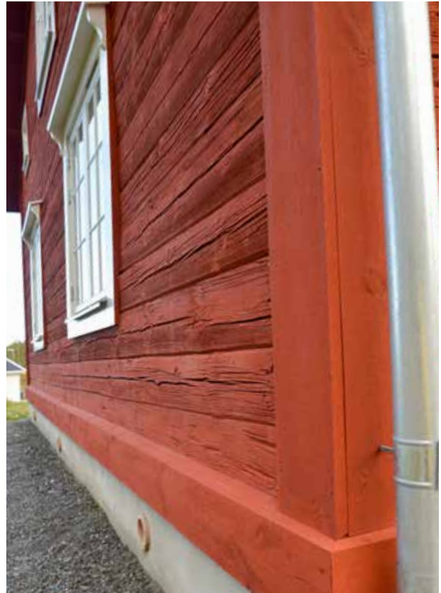
Rödmålad timmerstomme och röda knutbrädor fungerar bra med grå putsad grund och förzinkade plåtdetaljer. Notera även grundens ventilation i form av tegelrör. Huset finns utanför Askersund.
