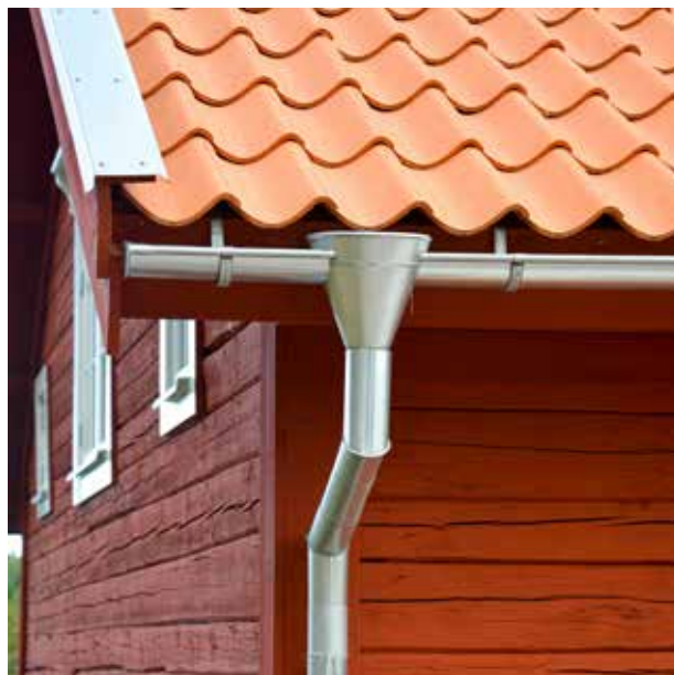
Enkupigt lertegel och fina detaljer i förzinkad plåt.
