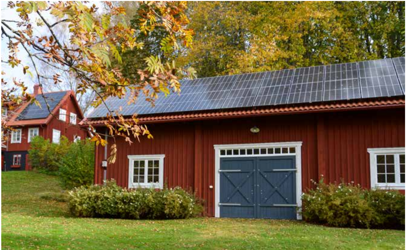
Snavlunda: Ett helt nybyggt garage som samspelar med boningshuset.
