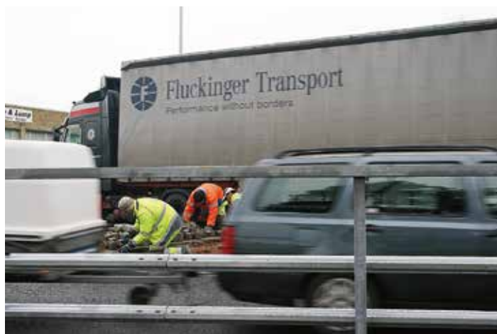
Arbetena med rondellbygget pågick under drygt sju månader.
