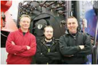
LaxåVärme personalstyrka framför nya flispannan: Mats Gustafsson, fjärrvärmechef, Jens Fredriksson, drifttekniker, och Per Arkhed, driftmaskinist.
