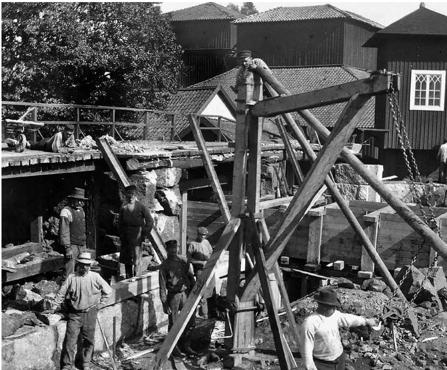
Ombyggnad av Smeddammens luckor 1907.
