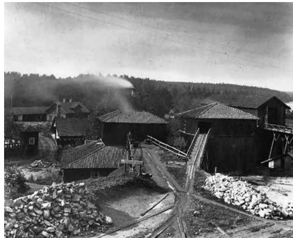
Hyttan, rostugnen och kolhuset. Till vänster klensmedjan, turbinhuset och hammarsmedjan. I bakgrunden ekonomibyggnad och brukskontor. Bilderna har hämtats från Arkivcentrum i Örebro av Hasselfors Byalags Cristina Söderberg.
