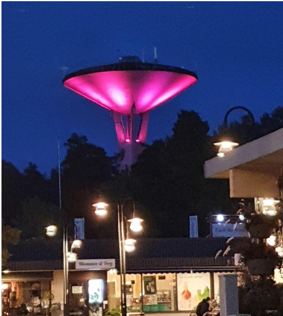
Laxå Vattentorn lyser över Centrumtorget i Laxå
