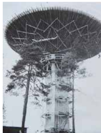
Laxå vattentorn under uppförande 1961.
