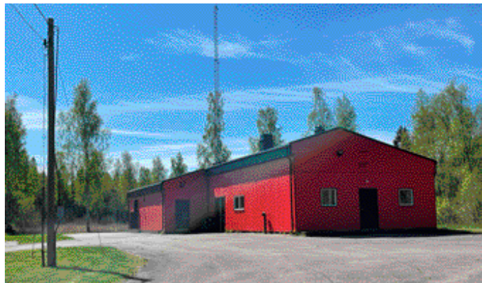
Nyrenoverat reningsverk i Hasselfors.
